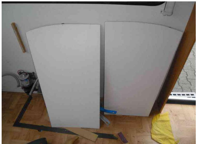
**Jetzt werden wieder mit den Schablonen die Rundungen angezeichnet. Also oben und unten ganz genau Beginn und Ende der Rundung, zuerst aufs Papier, dann auf die Oberseite der Platte und zuletzt auf die Rückseite übertragen. Da der Radius der Rundung oben sehr klein (fast 0) und unten größer ist, ergibt sich dann so eine Keilform.**
