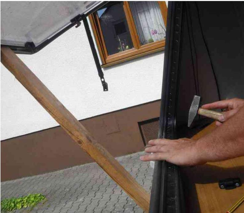
Leicht hochstehende Tackerklammern werden gleichmäßig eingeklopft
