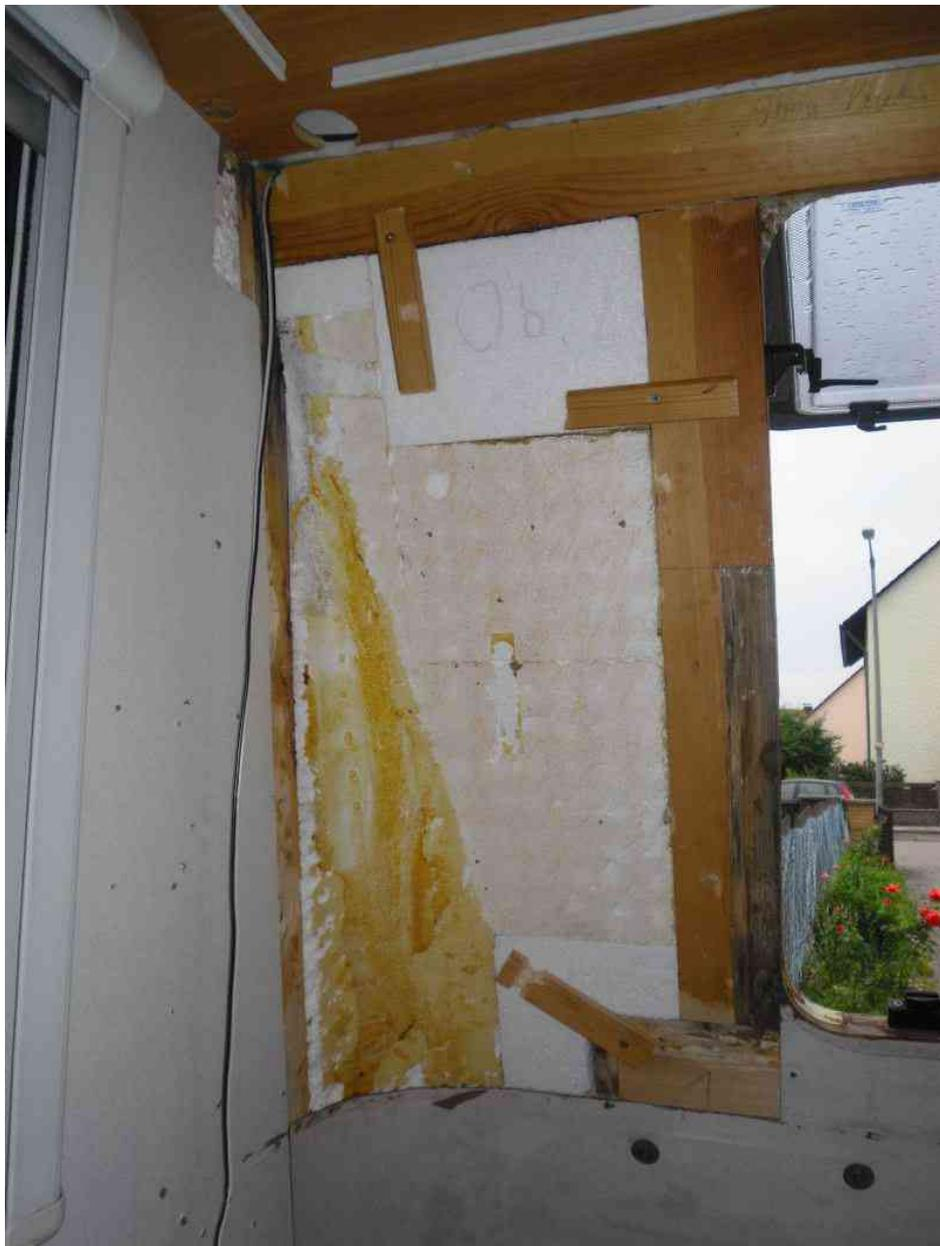
**Eingeklebte Styroporplatten werden mit Latten angedrückt**
